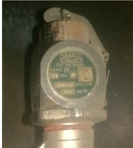
Figura 2.6. Válvula de alivio
