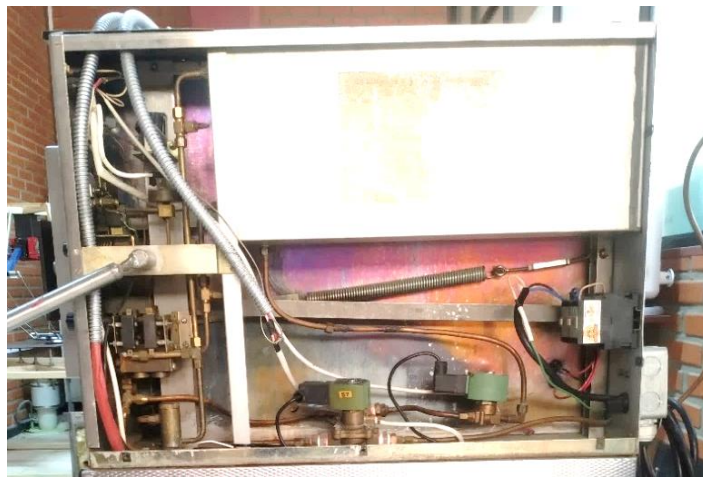
Figura 2.7. Estado circuito de tuberías
